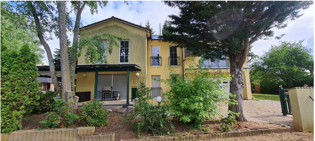
Abbildung 5: Ansicht des Gebäudes in der Donellusstraße 9, Blick von Süden; (Foto: Bachmann Artenschutz GmbH)
