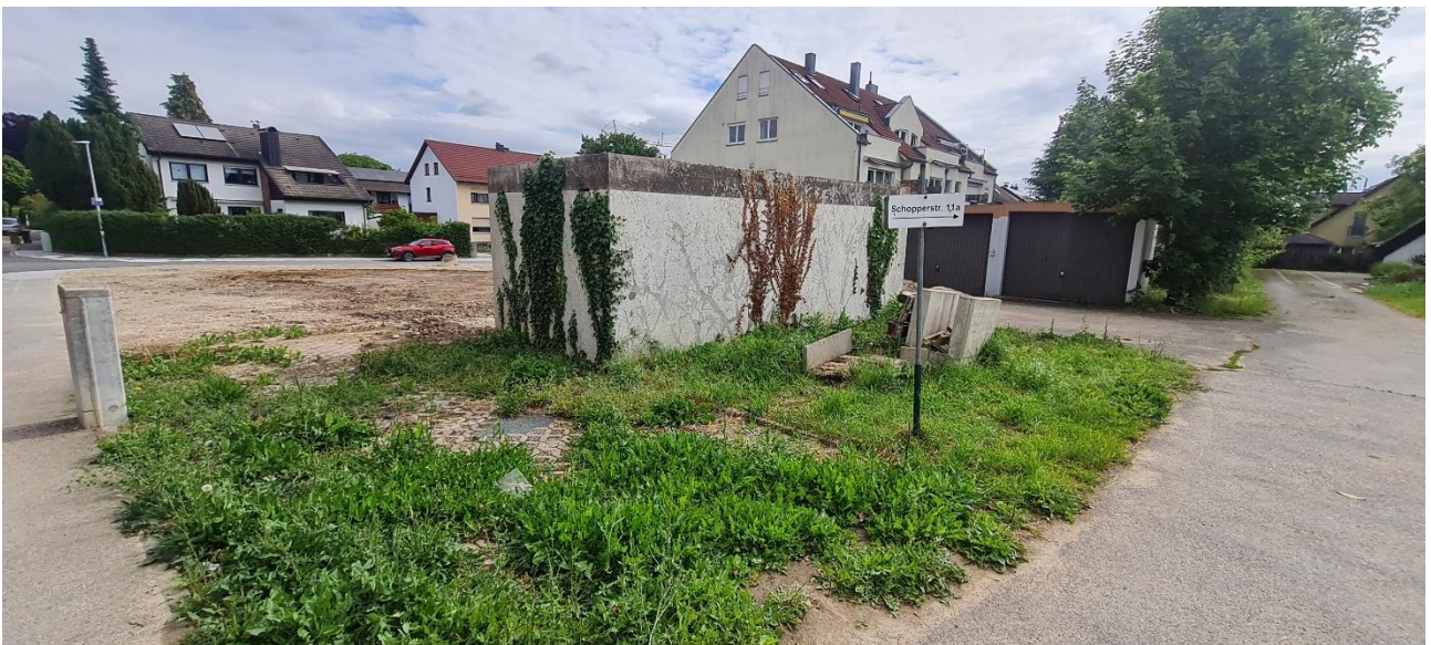
Abbildung 10: Ansicht des Lagerplatzes während der Straßensanierung „Schopperstraße“; im Bereich der Schopperstraße 11 inkl. Bestandsgaragen; (Foto: Bachmann Artenschutz GmbH)
