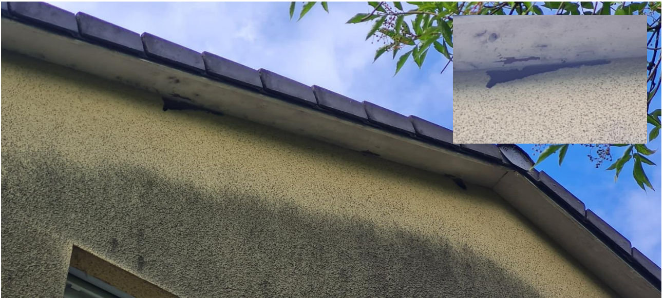
Abbildung 9: Ansicht des Gebäudes in der Donellusstraße 9, Blick auf die Spechtlöcher in der Isolierung des Hauses; (Foto: Bachmann Artenschutz GmbH)
