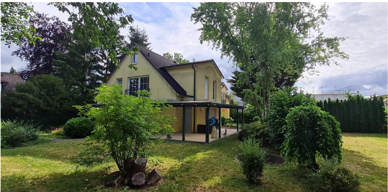
Abbildung 4: Ansicht des Gebäudes in der Donellusstraße 9, Blick von Süden; (Foto: Bachmann Artenschutz GmbH)
