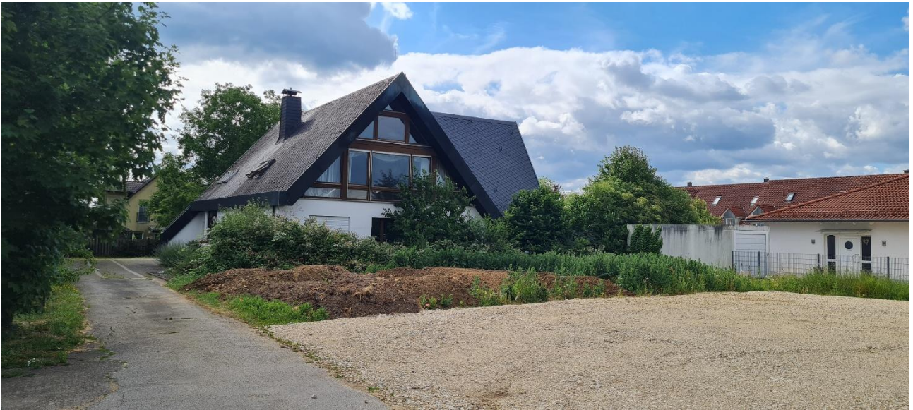
Abbildung 11: Ansicht des Abrissgebäudes in der Schopperstraße 11a, mit vorgelagertem Aushublagerplatz; (Foto: Bachmann Artenschutz GmbH)
